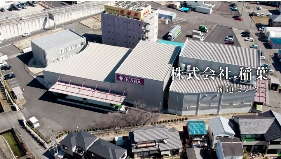
01 流通センターの全景
